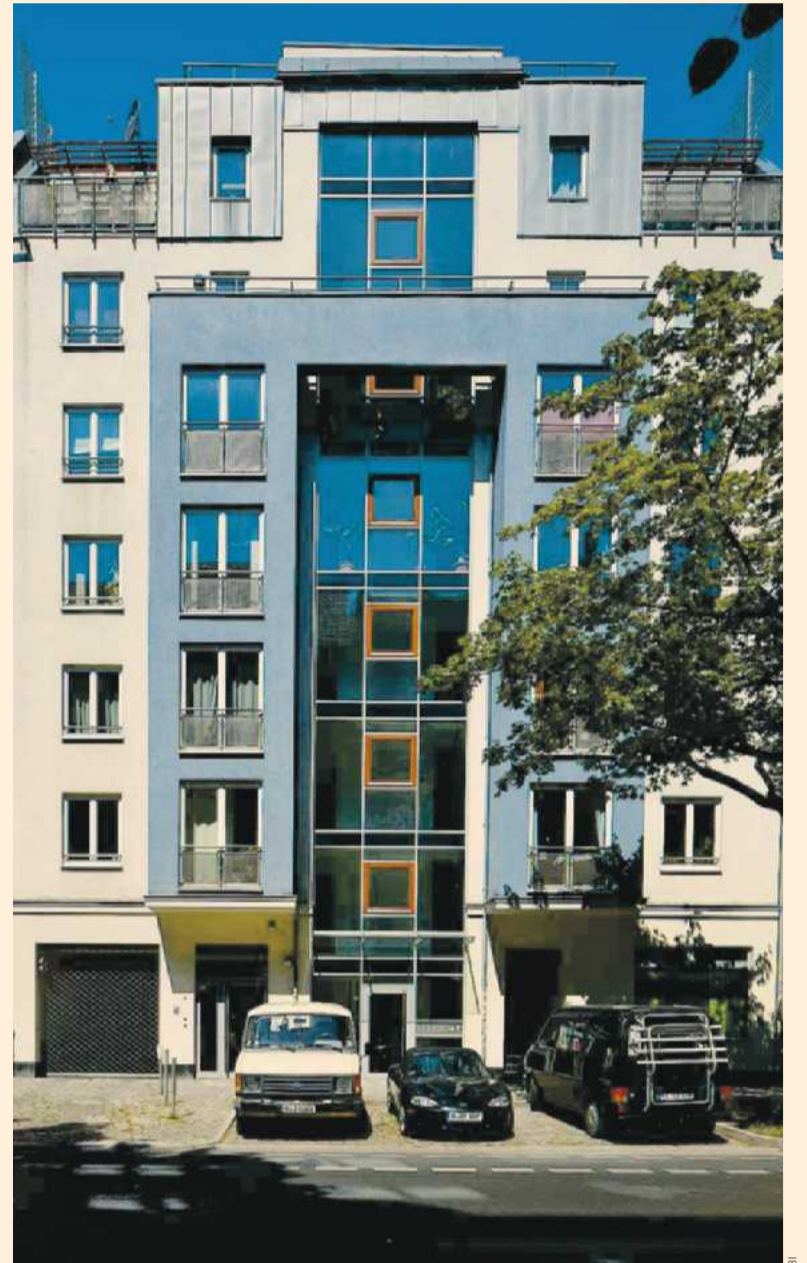
Für den Vorgängerfonds gekauft: Wohn- und Geschäftshaus mit 28 Wohneinheiten und einer Gewerbeinheit an der Neuen Bahnhofstraße in Berlin-Friedrichshain
